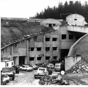
Bau des Krafthauses
